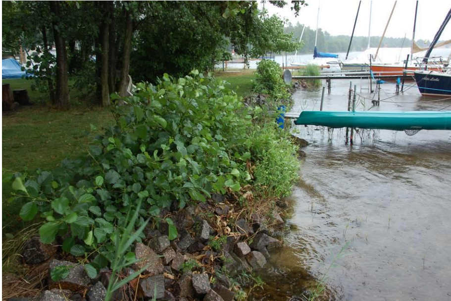
Abbildung 4: Uferbereich an der Halbinsel
